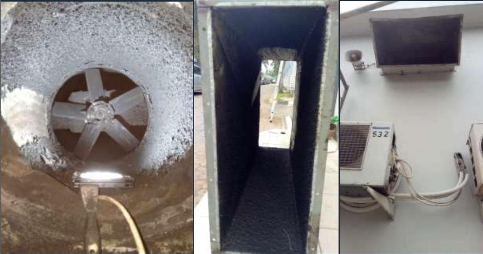
Foto: Kondisi exhaust ducting kitchen – penumpukan minyak memerlukan perawatan rutin.
